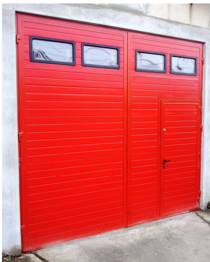
Rys. 6. Brama dwuskrzydłowa z furtką i okienkami
